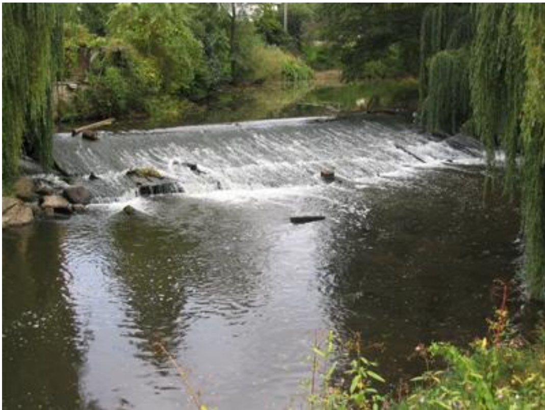
Das Wehr in Erdesbach
